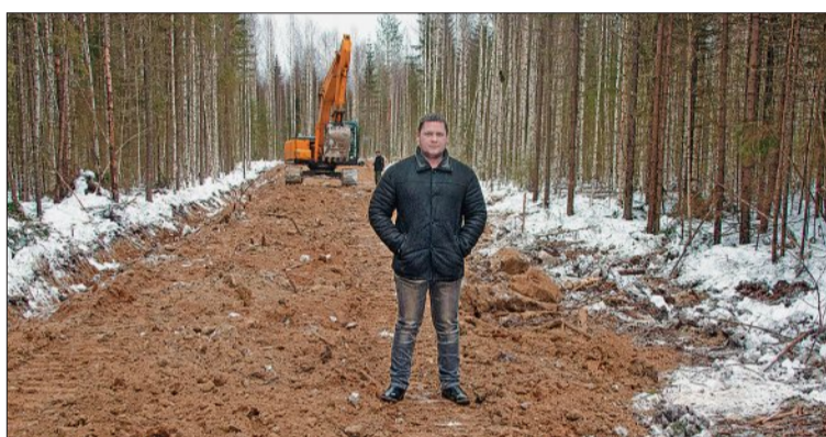
Алексей Лукичев проверяет, как проходит строительство дорог в Ломоватке.
