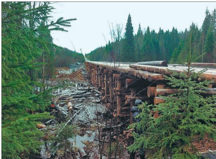
В 2014 году был построен железнодорожный мост через реку Поршу.
